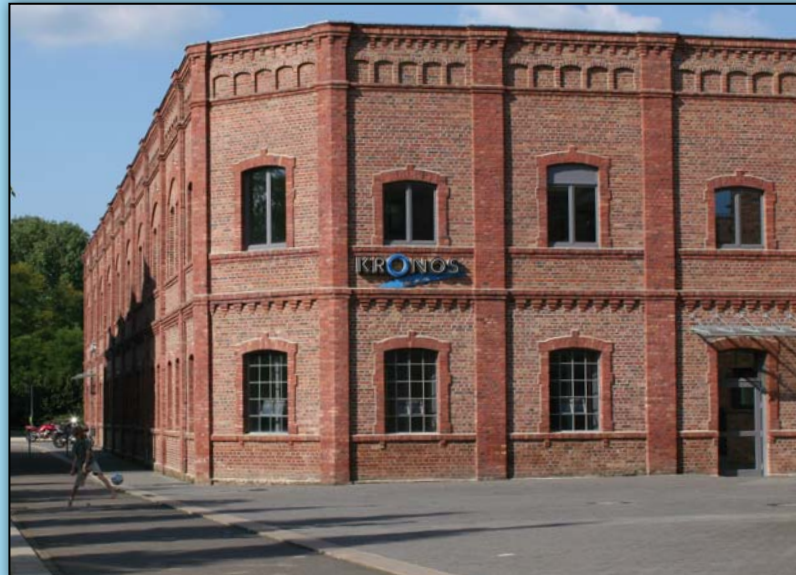
Der Hochbau heute: der einzig erhaltene Teil des früheren Chronos-Werks
