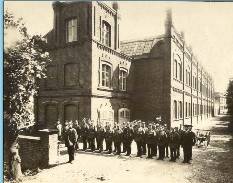
Feuerwehrturm und Hochbau mit der Löschgruppe der Hennefer Feuerwehr um 1926
